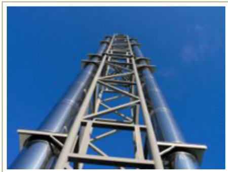
Предназначены для отвода дымовых газов и продуктов горения от котлов в котельных установках и рассеивания их в атмосфере.
