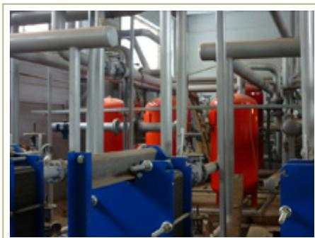
Пункты выпускаются со схемами теплообмена «вода-вода», «пар-вода», также в качестве нагреваемой среды может быть этиленгликоль, диатермическое масло и др.
